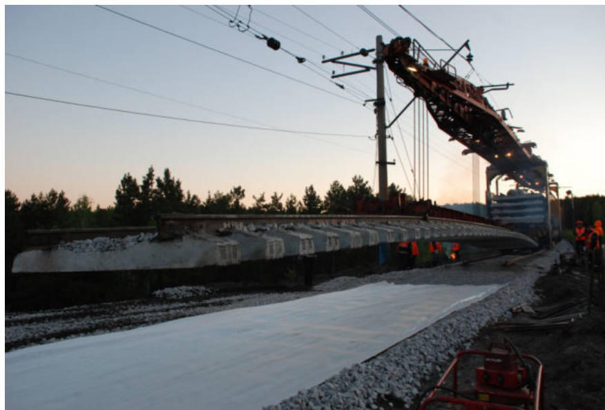
Капитальный ремонт пути и стрелочных переводов
