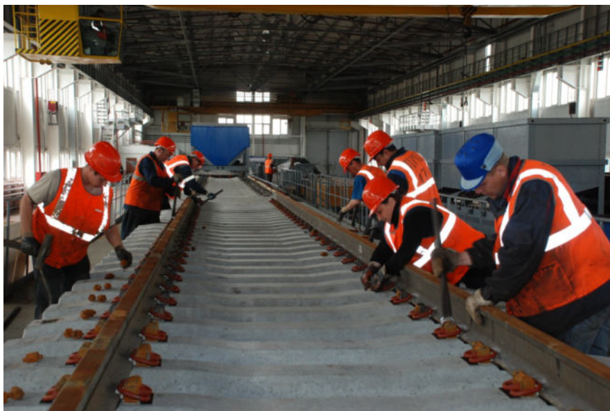
Сборка рельсошпальной решетки
