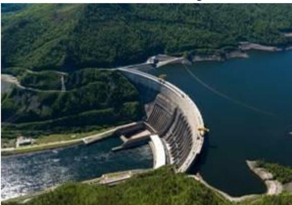
Чтобы производить гидроэлектричество, необходимо наличие трёх компонентов: движущейся воды, турбины и генератора. ГЭС – это заводы, которые преобразуют энергию падающей воды в электричество. Плотина строится через реку, чтобы поднять уровень воды, с которого может осуществляться её падение, необходимое для развития движущей силы. Проточная вода поворачивает колесо турбины, которое соединено с генератором. Генератор имеет ротор, который
